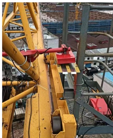
找到塔司经常停小车的位置，首先将充电桩垫板安装在小车扶手架上，注意充电桩垫板与充电桩之间的距离，不要相隔太远，这样支架伸出来太长，容易晃动，利用配套的安装箍将垫板固定在小车扶手架上，找到相对应的位置，安装上充电桩。
